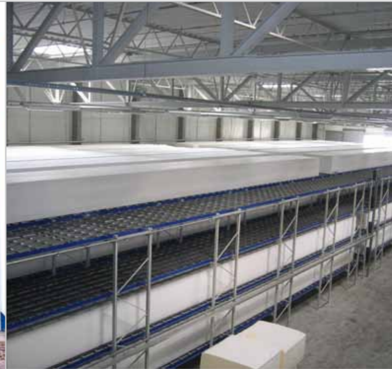
Échafaudage de rayonnages intégré à la construction de la salle
