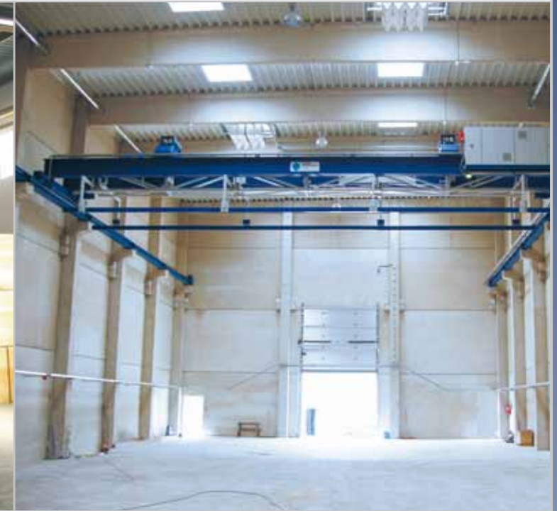
Système de levage de bloc à structure en pont rapportée
